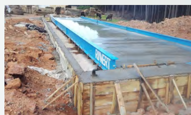
Concretagem da Pista
